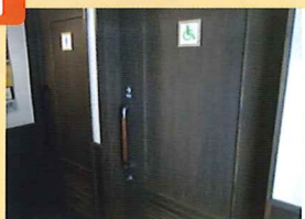
引き戸になったトイレ
