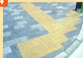
点字ブロック
